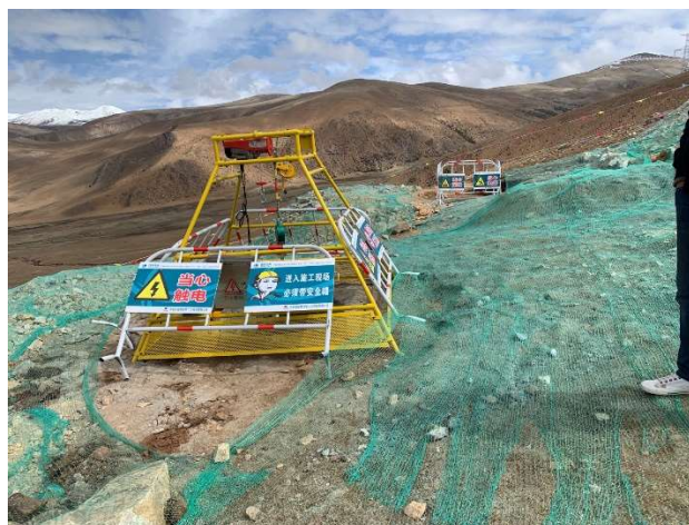
Figure 3. Actual construction site
